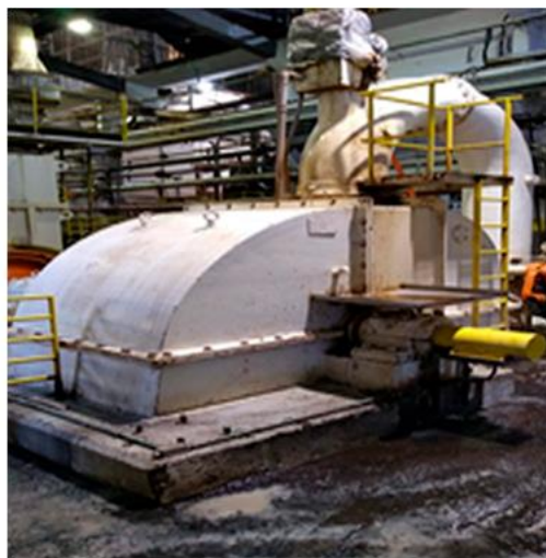
ANTES DA REFORMA
